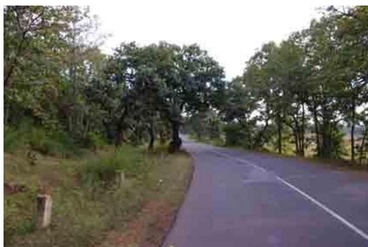
写真：南セオニ区間付近の国道 7 号線の現状（片側 1 車線）
